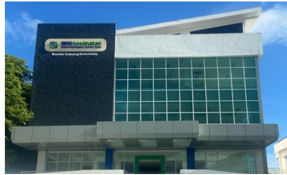
Gambar 1. Fasad gedung BPJS Kesehatan cabang Gorontalo
